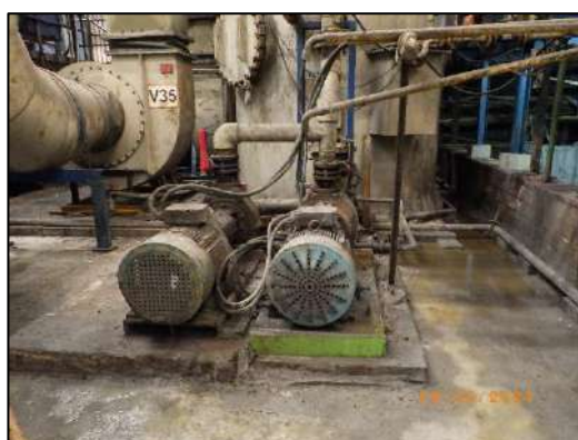
รูปที่ 2-3 ป้อนน้ำที่ใช้ในระบบ Scrubber
