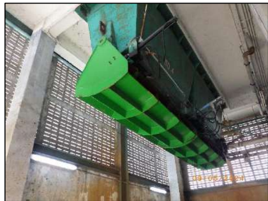
รูปที่ 2-27 ถังเก็บ (Hopper) สำหรับรวบรวมตะกอนจาก ระบบบำบัดน้ำเสียเคมี (WWT Sludge)
