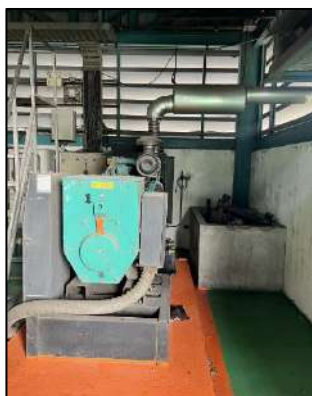
รูปที่ 2-2 เครื่องกำเนิดไฟฟ้าสำรอง (Emergency Generator) สำหรับระบบ Scrubber
