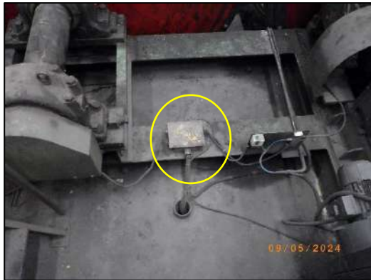
รูปที่ 2-46 การติดตั้งสายดินของเครื่องจักรและอุปกรณ์ไฟฟ้าภายในโครงการ
