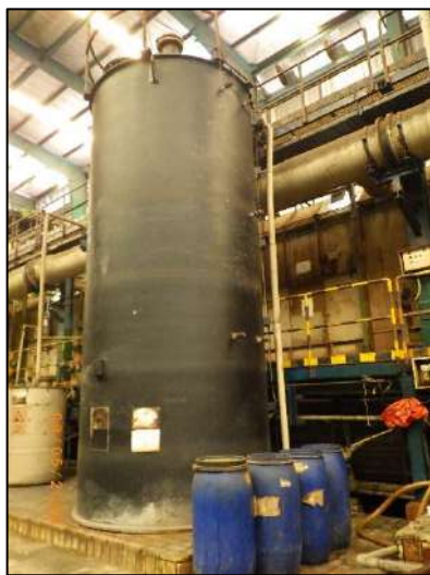
ถังเก็บกักน้ำกรดที่ทำจากวัสดุทนการกัดกร่อน
