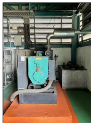
รูปที่ 2-2 เครื่องกำเนิดไฟฟ้าสำรอง (Emergency Generator) สำหรับระบบ Scrubber
