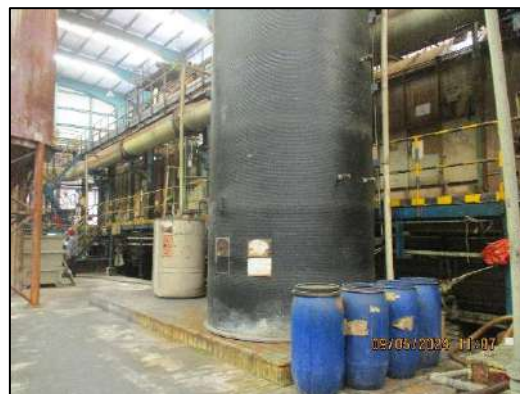
บริเวณพื้นที่รองรับถังเก็บกักที่ทำจากวัสดุทนการกัดกร่อน
