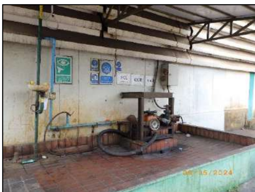
รูปที่ 2-48 Bund wall บริเวณจุดเติมและรับกรดไฮโดรคลอริก
