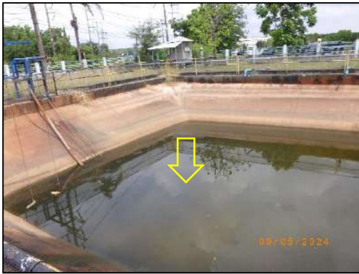
บ่อพักน้ำทิ้งขนาด 400 ลูกบาศก์เมตร (Effluent Pond)
